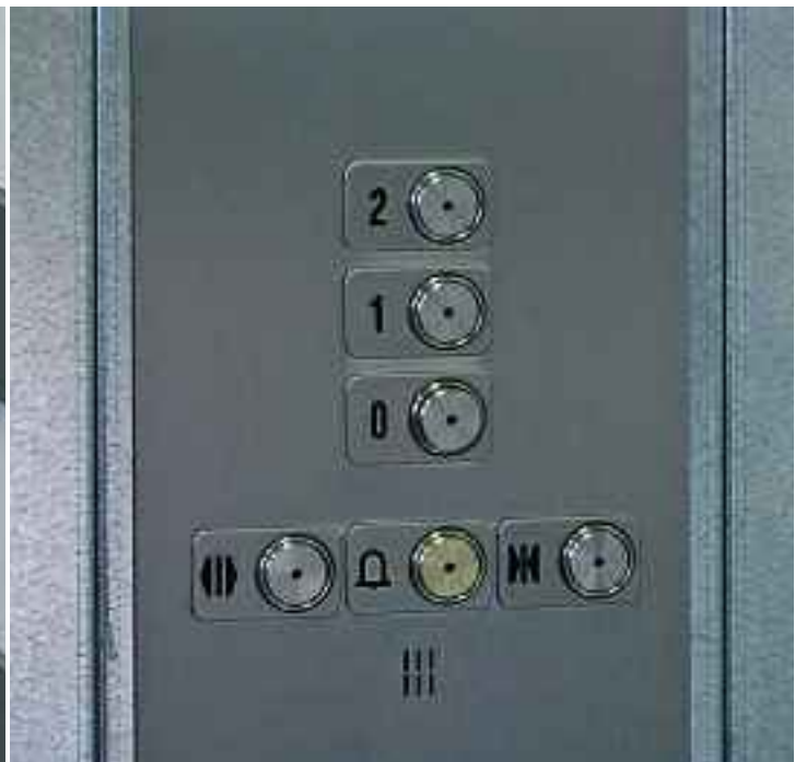
Bottoniera di cabina in acciaio inox, anti-vandalo
